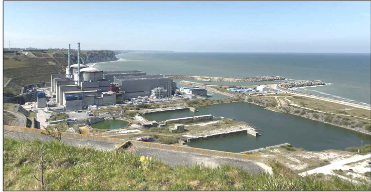
Centrale nucléaire de Penly, dans le département de la Seine-Maritime (© EDF)
