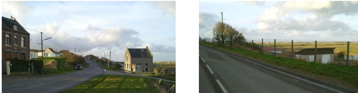
Entrée dans le Vieil Onival
